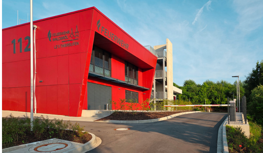
■ Neubau und Modernisierung der Feuerwehr
