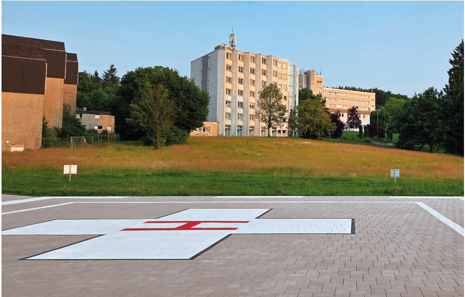
■ Auch das Krankenhaus Waldbröl hat einen neuen Hubschrauberlandeplatz bekommen
