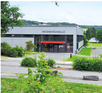
■ Die Heidberghalle wurde im vergangenen Jahr umfassend saniert
